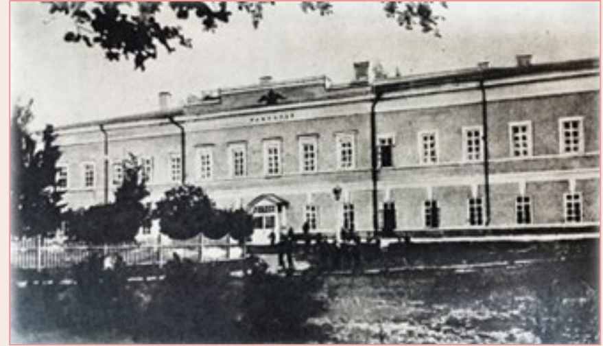
Будівля Новгород-Сіверської гімназії, де навчався К. Д. Ушинський
