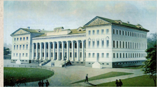
Центральний корпус Ніжинського університету
